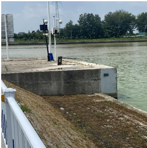
图 2.2-5 西侧护坡区现状图 1
