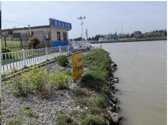
图 2.2-6 西侧护坡区现状图 2
