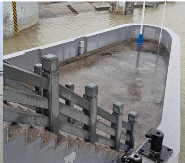
2.2-9 东侧护坡区现状图 2
