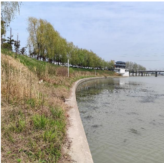
2.2-8 东侧护坡区现状图 1
