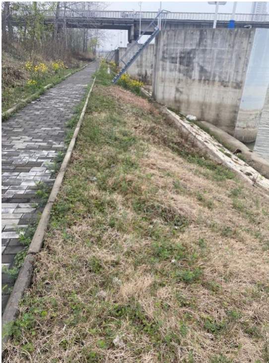
2.2-11 北侧护坡区现状图 1
