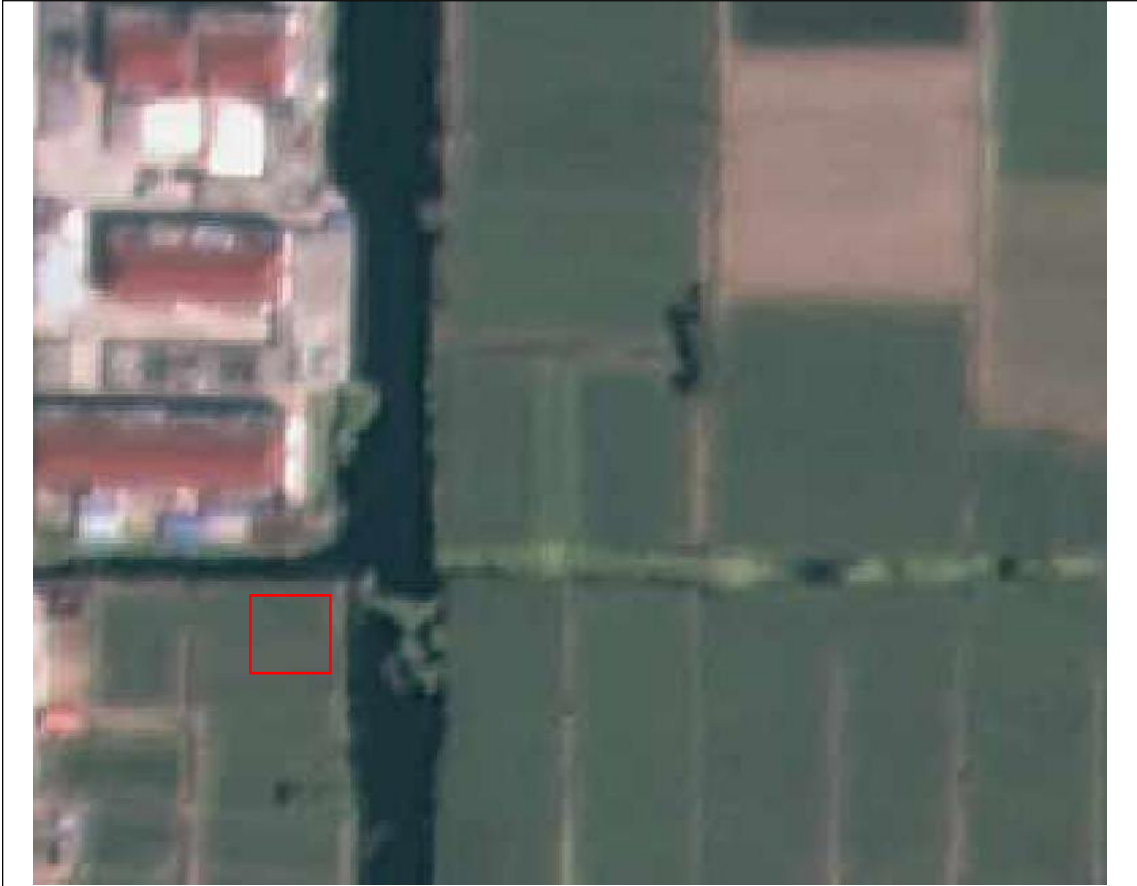
T1塔施工前（2023年5月）
