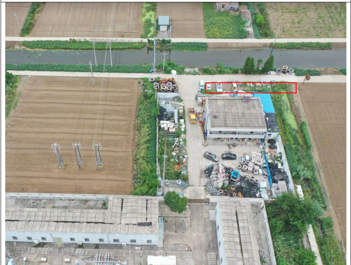
电缆施工区现状（2024年9月）
