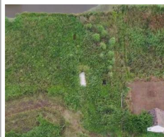
电缆施工区 撒播草籽 (2024.09)
